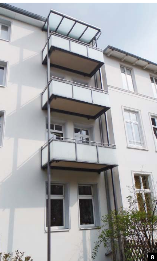
Abb. 8: Eine Vorstellanlage ersetzt seither die alten Balkone. Um nicht mehrere dickere Stützen verwenden zu müssen, haben die Architekten die Verankerung sowohl an den unteren Tragkonstruktionen als auch in der Nähe der Handläufe eingeplant.
