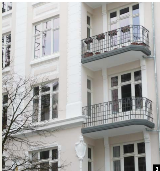
Abb. 3: Ein Profil an der Balkonkante und Dekorelemente aus den alten Geländern passen die neuen Balkone optisch an die Fassade des denkmalgeschützten Altbaus an.
