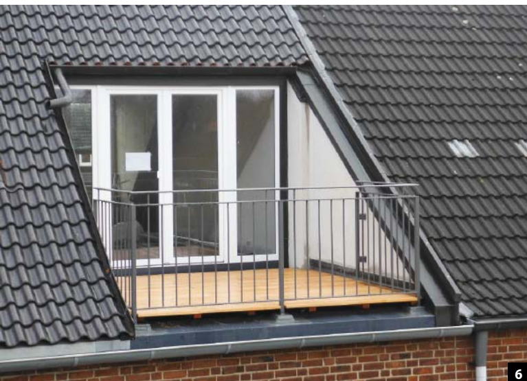
Abb. 6: Die wasserführende Ebene verläuft unter den Warften, auf denen das Geländer befestigt ist, und der Trittfäche. Damit ist der Aufbau reversibel.
