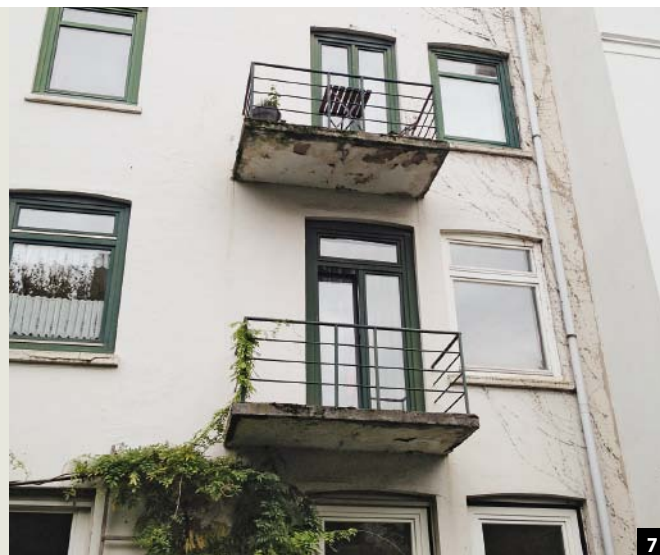
Abb. 7: Bei diesem Altbau sollte im Rahmen einer Energetischen Sanierung die Fassade gedämmt werden. Um die Dämmung wärmebrückenfrei aufbringen zu können, wurden die Balkone abgesägt.
