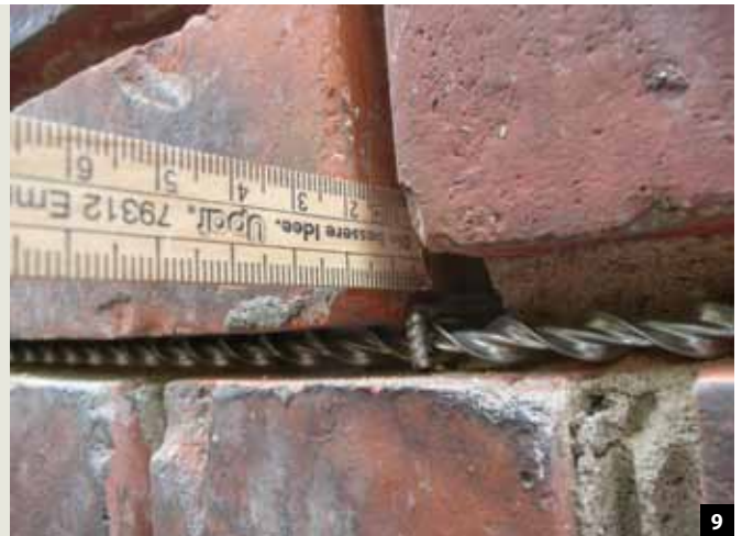
Abb. 8/9: Das ursprüngliche Konzept sah vor, die Fassade in der Fläche mittels Spiralankern zu stabilisieren. Speziell angefertigte Sanierungsanker sollten die Vormauerschale mit der Hintermauerung verbinden.
