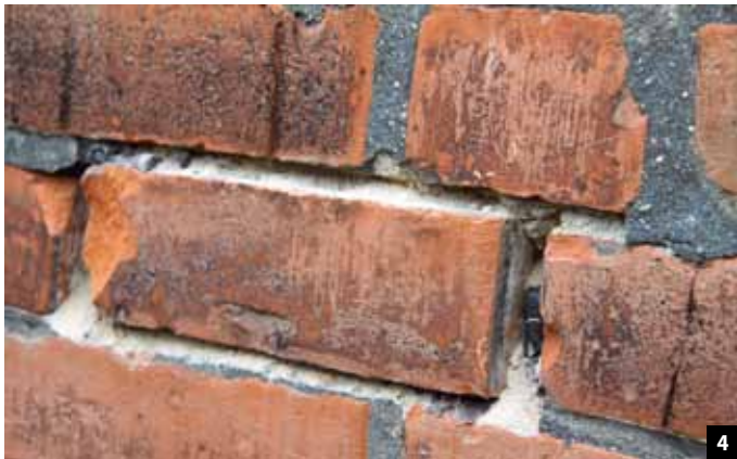
Abb. 4/5: Die Beprobungen ergaben „keine hydrophobe Eigenschaften“ beim Mauermörtel. Hier entfernte man probeweise einige Fugen mit einem Meißel. Der Stein ließ sich anschließend von Hand aus dem Mauerwerk rütteln.
