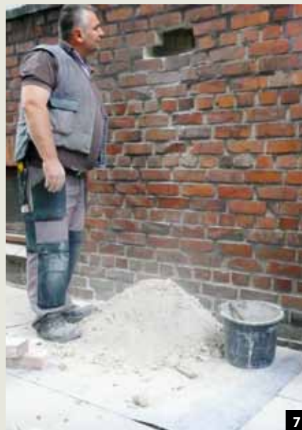
Abb. 7: Keiner der Beteiligten hatte mit einem derart massiven Versagen des Mörtels gerechnet.
