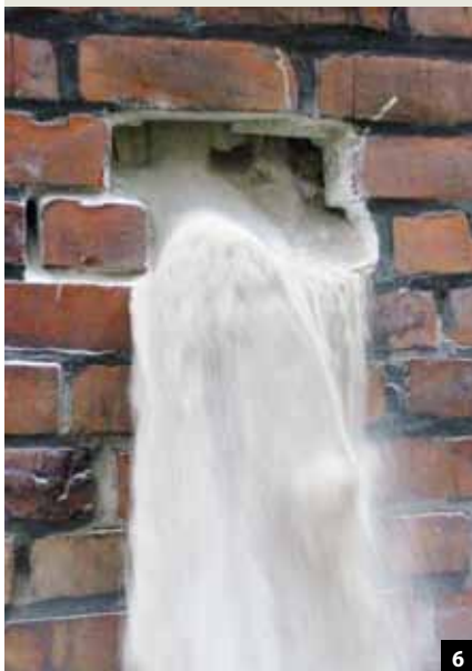
Abb. 7: Keiner der Beteiligten hatte mit einem derart massiven Versagen des Mörtels gerechnet.
